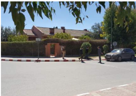
Le local qui abritera la nouvelle agence ANAPEC YOUSOUFIA située à côté du Futur quartier administratif
