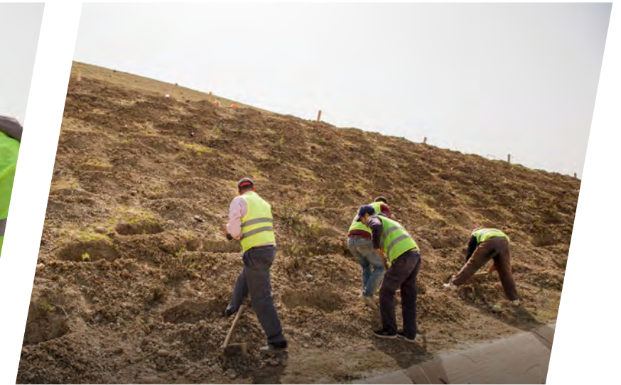
معالجة منحدرات الطرق السيارة عن طريق الزراعة والتغطية بالقش لتثبيت التربة
